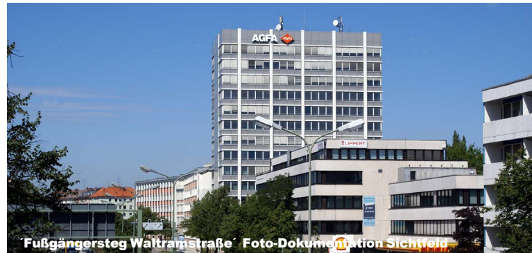
Fußgängersteg Waltramstraße Foto-Dokumentation Sichtfeld
